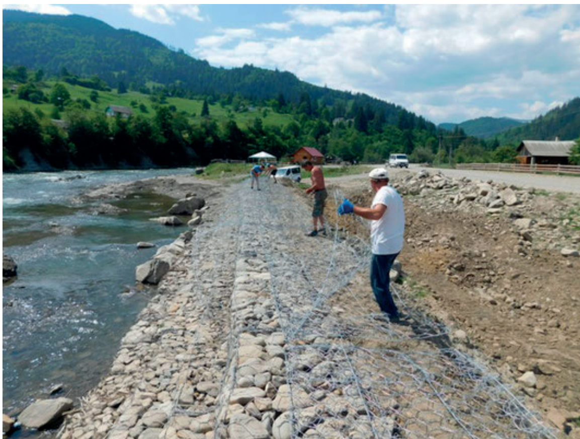
Рис. 5.1. Укладання берегоукріплюючих споруд на р. Черемош
