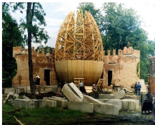
Будівництво Музею Писанки. 2000 р.
